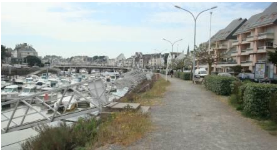
Promenade le long des quais (Source : Citadia, 2011)
