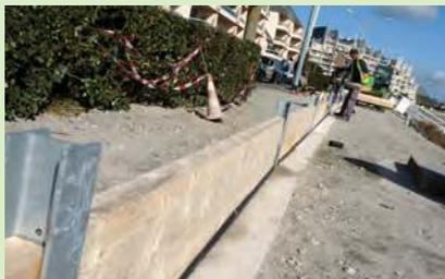
Dans l'attente de travaux définitifs, des mesures transitoires ont été prises. Au Pouliguen : renforcement de la digue de la Minoterie, et réalisation de batardeaux prêts à être installés sur le quai Commandant l'Herminier en cas d'alerte météo.
