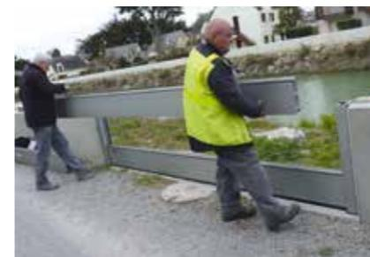
Batardeaux : barrage destiné à la retenue d'eau provisoire
