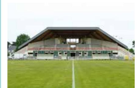
Débutés en janvier, les travaux du stade Félix Monville s'achèveront au cours des prochains mois. Au rez-de-chaussée, une extension a été créée permettant de réorganiser vestiaires, sanitaires et autres locaux techniques. Une nouvelle couverture en zinc et des menuiseries en aluminium ont été posées, garantissant des économies d'énergies. Peinture des façades et rénovation du bar extérieur sont aussi au programme. L'inauguration est prévue à l'automne.
