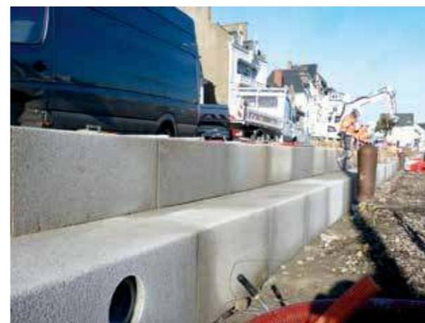
→ Côté étier, la première partie du muret existant (surmonté d'une rambarde) a été enlevée. Le remplacement par des gradins, qui viendront faire la jonction entre quai haut et quai bas, a débuté. Des points lumineux seront insérés dans les contremarches.
