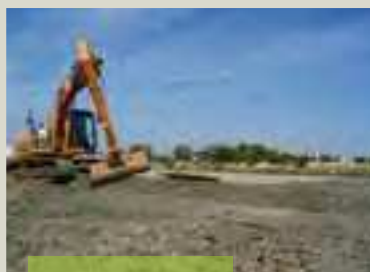
Pendant les travaux
