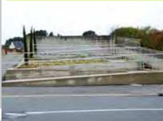
Rampe d'accès pour Personnes à Mobilité Réduite
