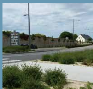
▲ Achévé en mai, les travaux du boulevard de Coubertin ont permis d'aménager, végétaliser et sécuriser cet axe largement fréquenté.
