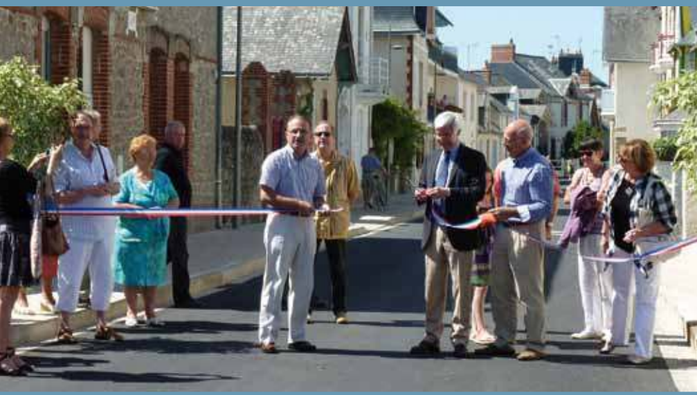
▲ Les rues Maréchal Joffre et Paul Lesage ont été entièrement rénovées. Elles ont été inaugurées juste avant la saison.
