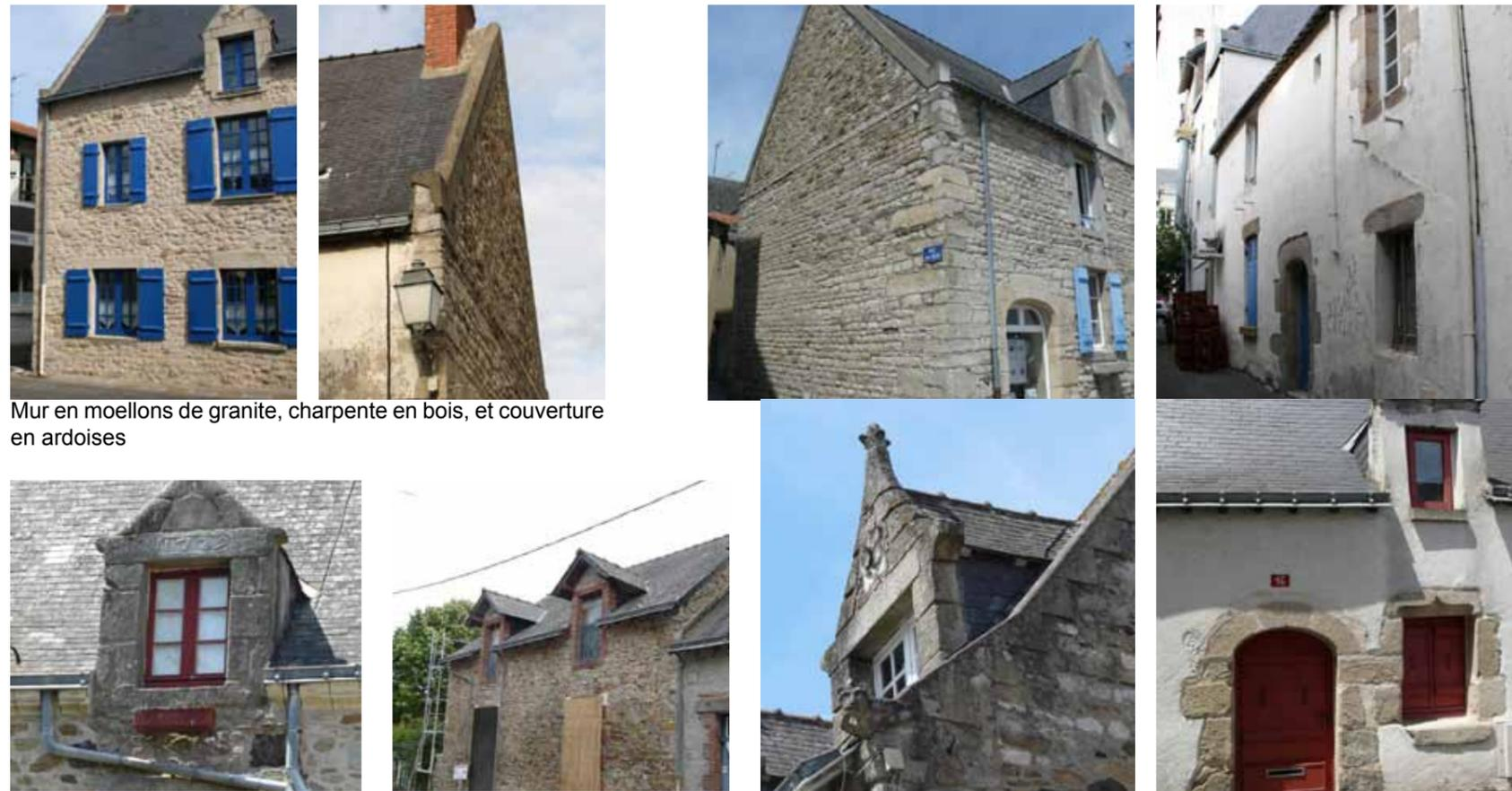
Mur en moellons de granite, charpente en bois, et couverture en ardoises
