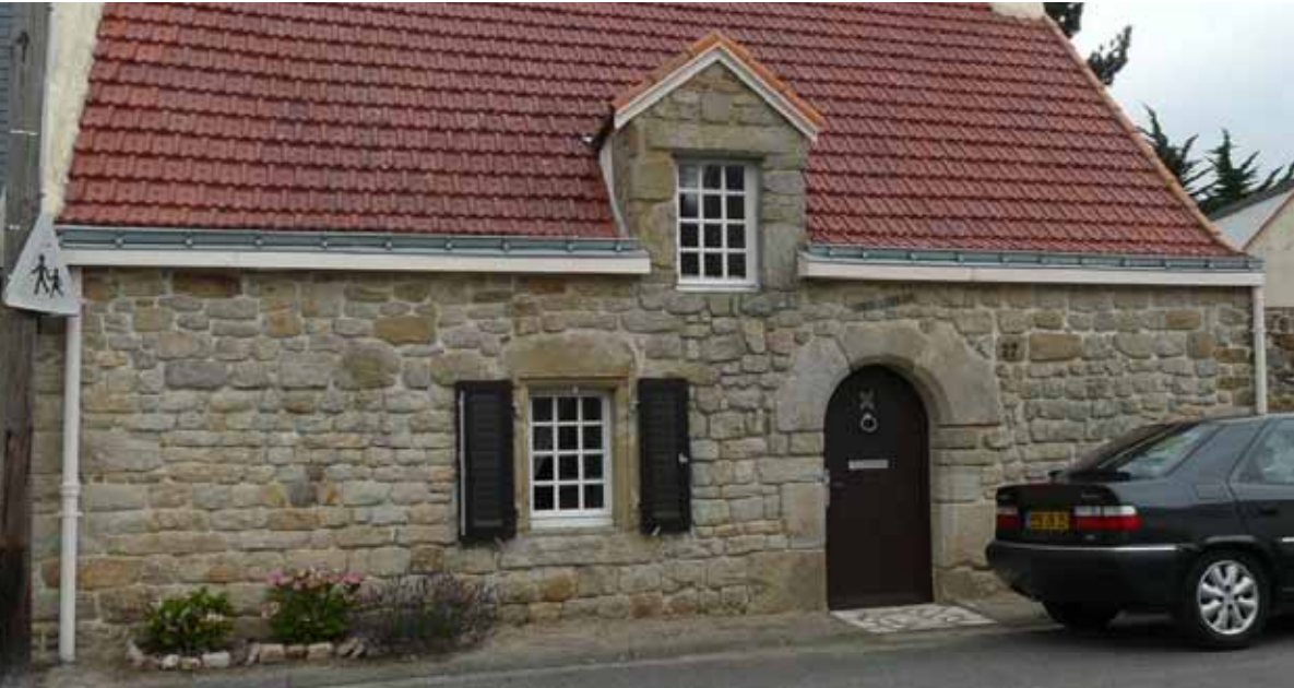
Façades en moellons de pierre apparents
