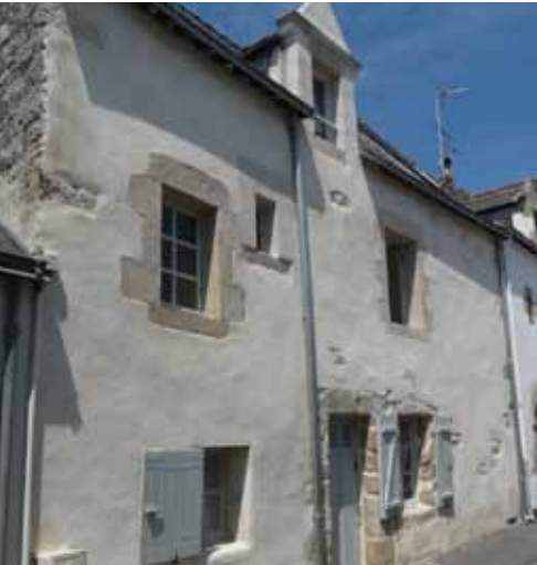
Façades recouvertes d'un enduit et badigeon
