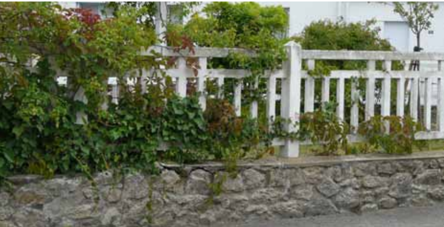
Muret + barrière en béton décorative
