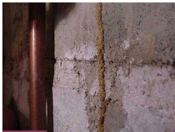
Construction d'une galerie tunnel (cordonnet) sur maçonnerie
