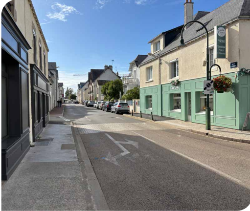
La Rue du Croisic avant les travaux
