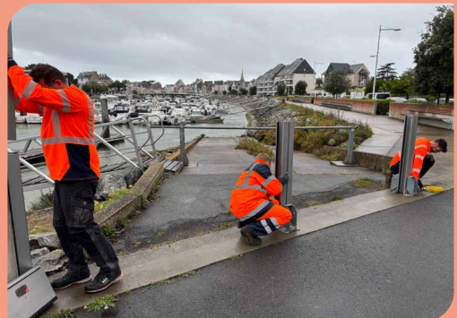
Pose des panneaux au niveau de l'étiéer par les agents de la Ville
