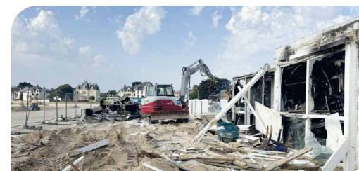
La structure calcinée a été démontée durant la dernière semaine de juin
